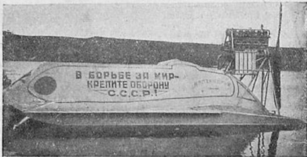
Глассер, построенный Ярославским кружком с мотором Холл-Скотт в 125 л. с. Скорость его с 7 пассажирами доходит до 65 км в час
