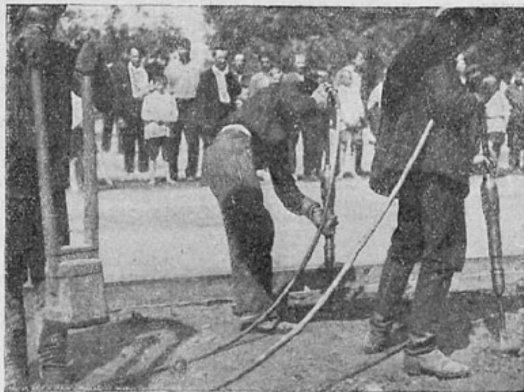
... Рабочий держит механическую трамбовку на весу, она силой сжатого воздуха утрамбовывает густую массу. Слева — рабочий с ручной трамбовкой
